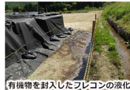
フレコン内で圧密固化
