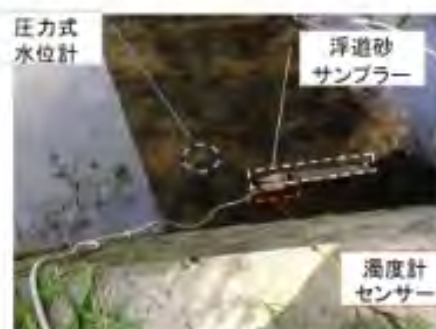
写真4. 浮遊砂サンプラー・濁度計センサー・水位計設置状況(口太川上流地点)
