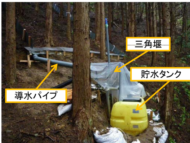
写真9 量水・土砂補足システム
