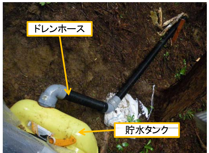
写真10 貯水タンクの排水システム
