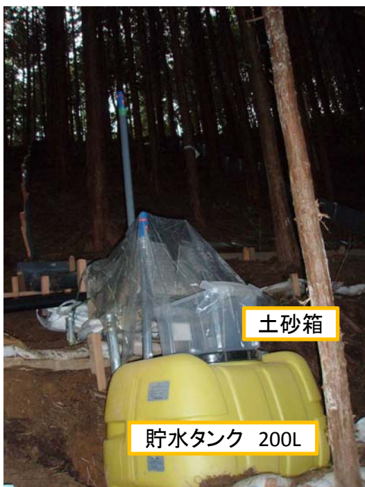
写真5 A3流域の三角堰と貯水タンクの設置概況(1)
