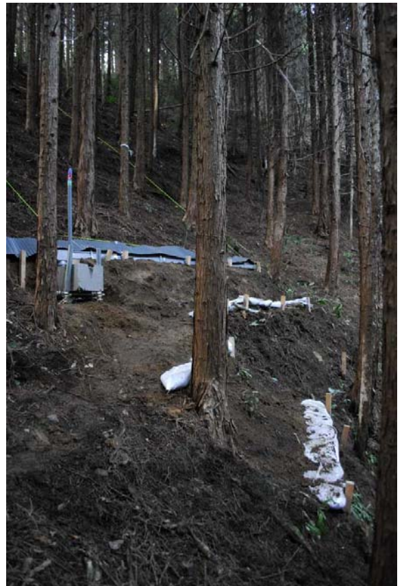
写真4 土砂流出抑止のための斜面施工
