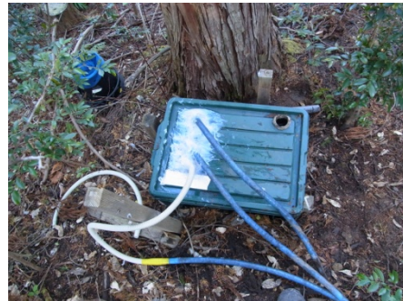
樹幹流の三角堰を補修
