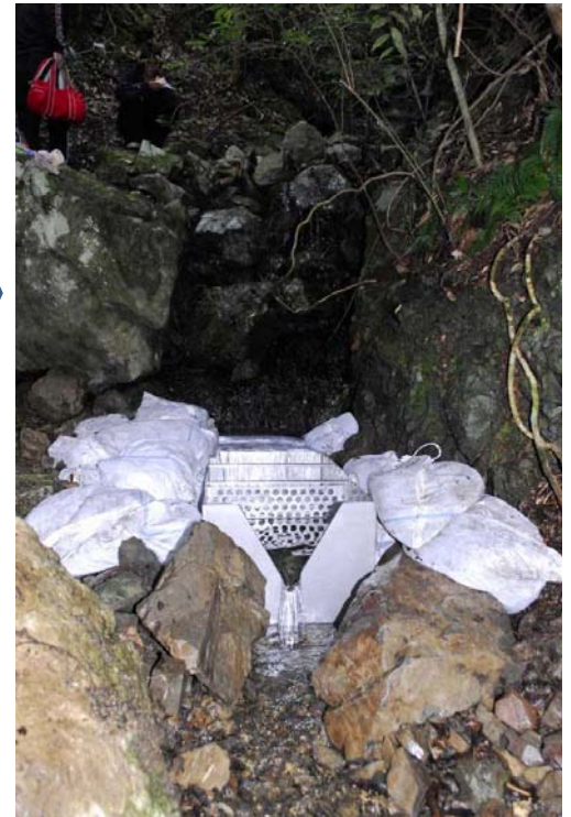
写真9 60度三角堰設置後 * 水位は19cm
