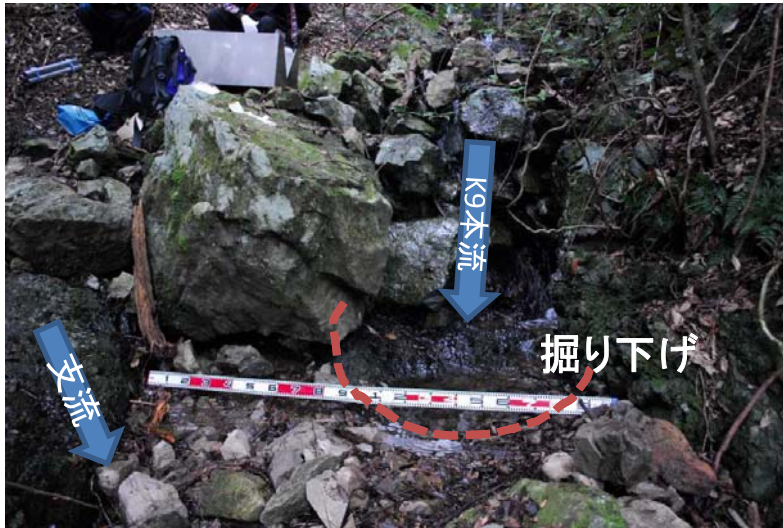
写真8 K9流域 三角堰設置場所
