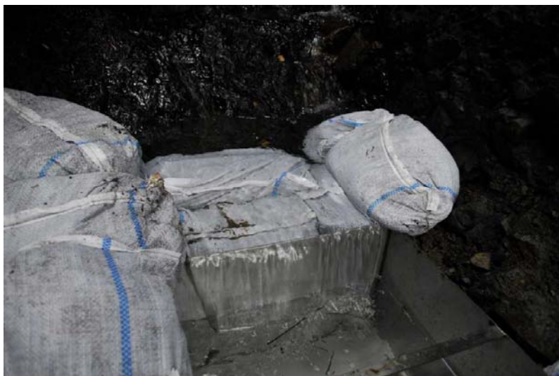
写真10 三角堰上流部の堰き止めの様子
