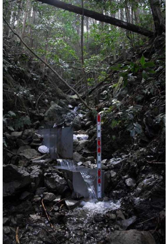
写真2 三角堰設置後
