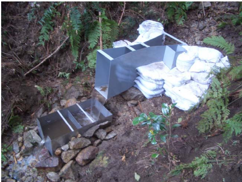
写真1 中間地点の5inchパーシャルと45度三角堰
