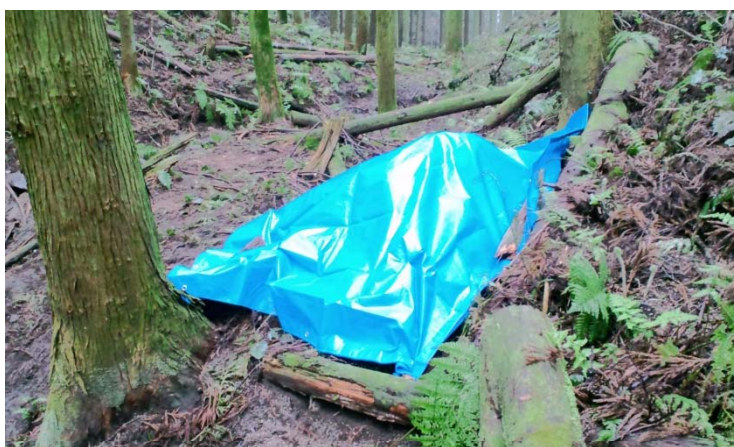
写真4 余った資材(単管, 土嚢袋など)の保管場所@最上流部量水堰
