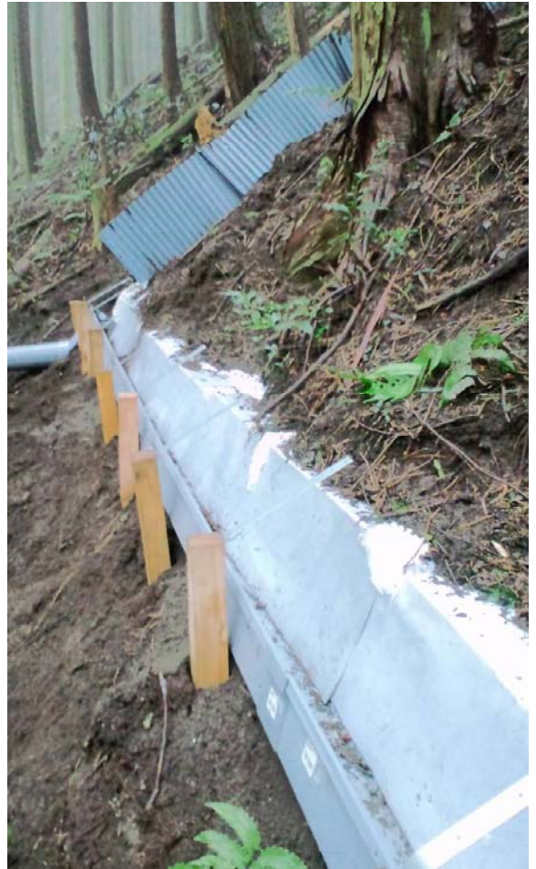
写真7 流出受け部分(1)
