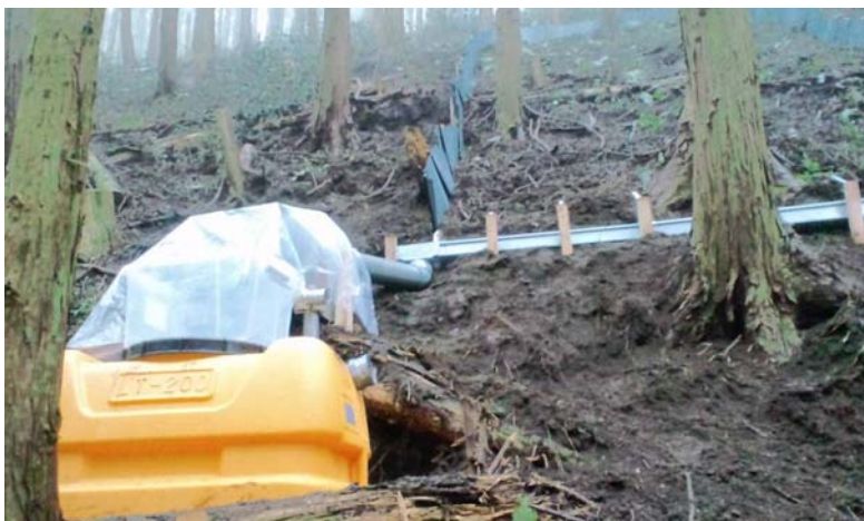
写真9 三角堰と貯水タンクの設置状況(この後、三角堰と貯水タンクにOdyssey水位計を設置済)
