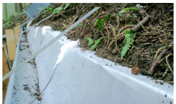
写真8 流出受け部分(2)
