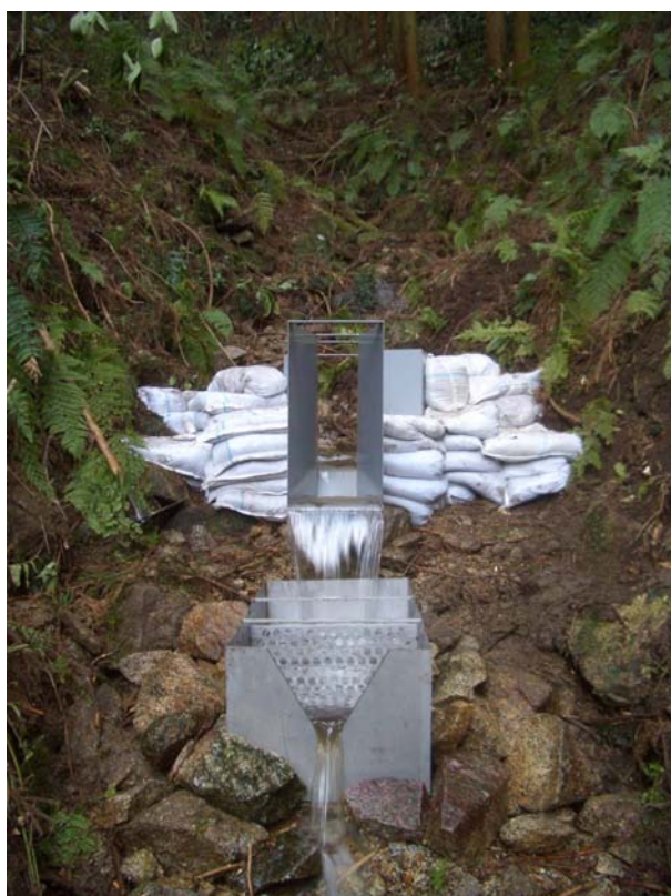
写真3 最下流地点の6inchパーシャルと60度三角堰
