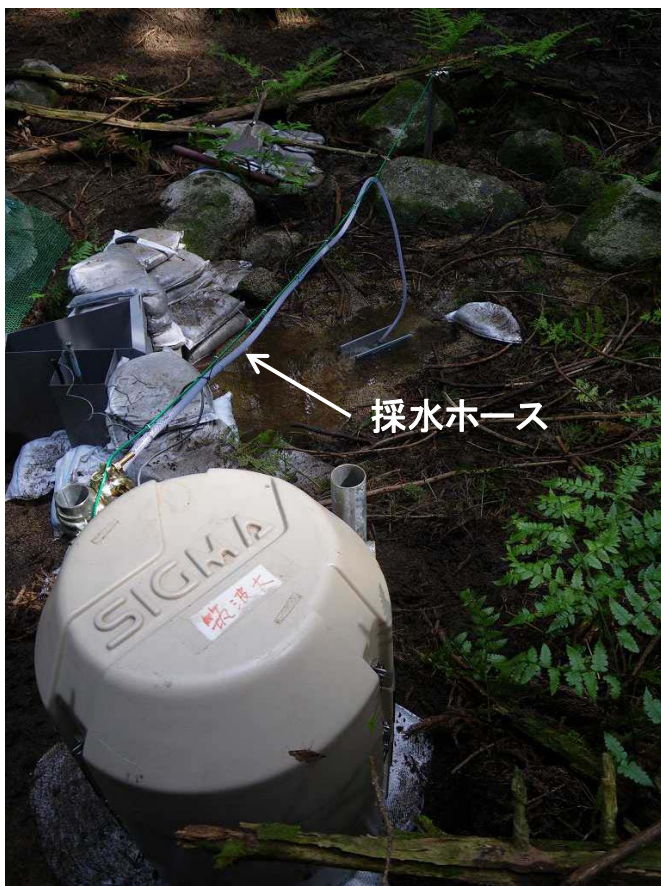
写真6 取水ホースの吊下げ方法
