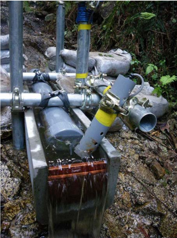
写真4 濁度計センサーの設置
