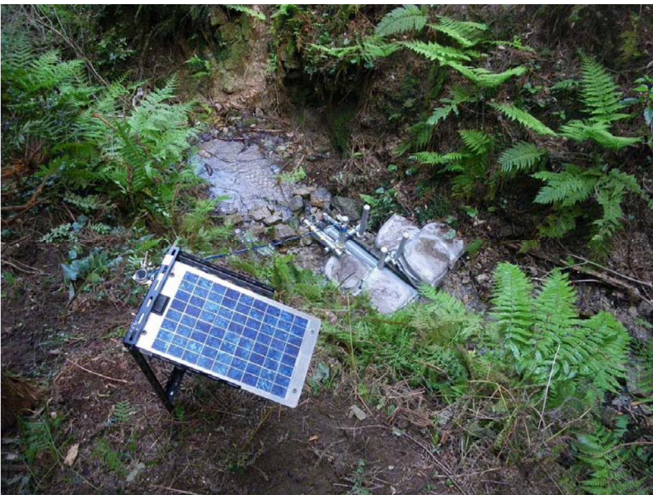
写真5 濁度計ロガーとソーラーパネルの設置
