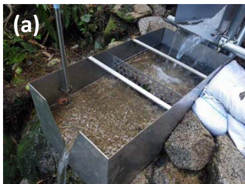
写真4 量水堰の状況
