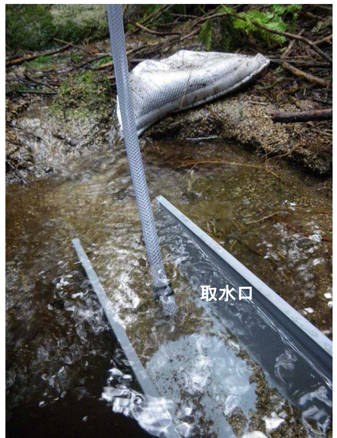
写真7 取水口の状況
