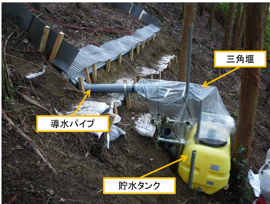
写真19 量水・土砂補足システム
