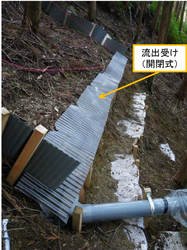
写真17 流出受け部分
