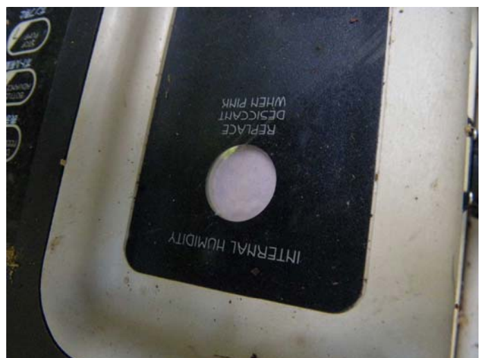
写真32 乾燥剤が取り替え時期(M4流域)
