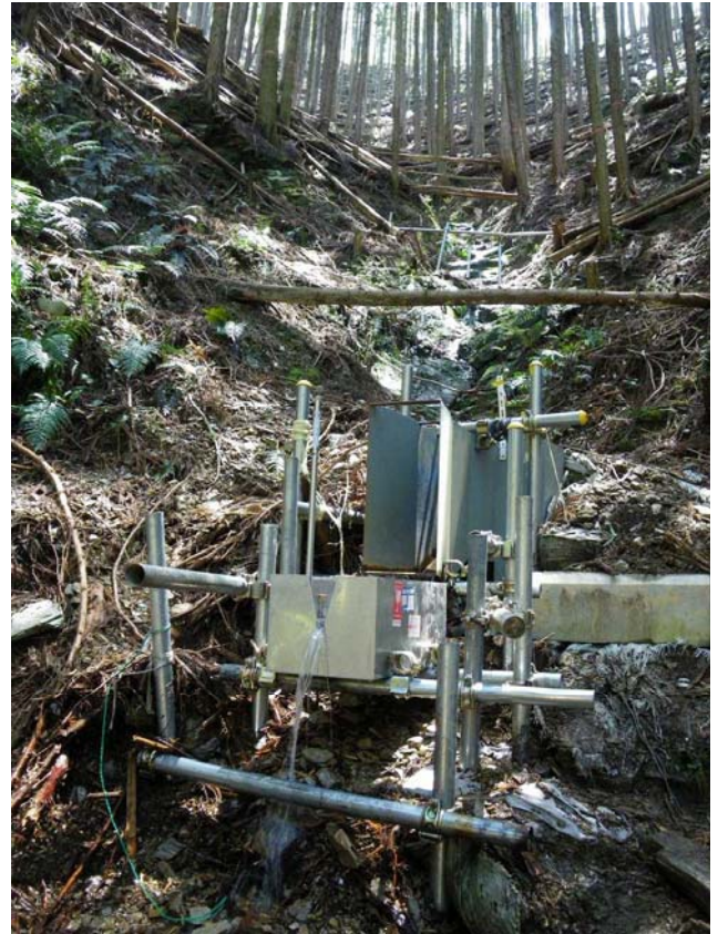
写真25 M5流域の量水堰
