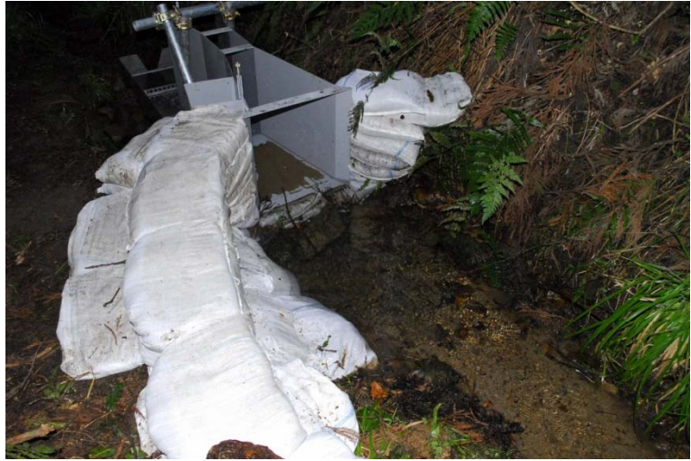
写真7 左岸側に設けた土嚢壁
