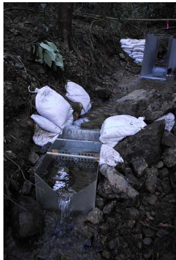
写真4 三角堰の設置状況 * 土囊の補強必要あり
