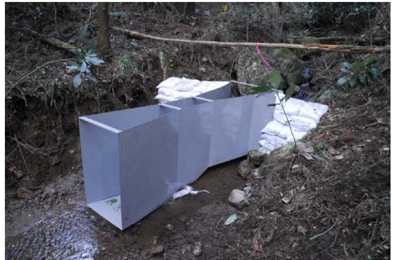
写真2 1ftパーシャルの設置状況
