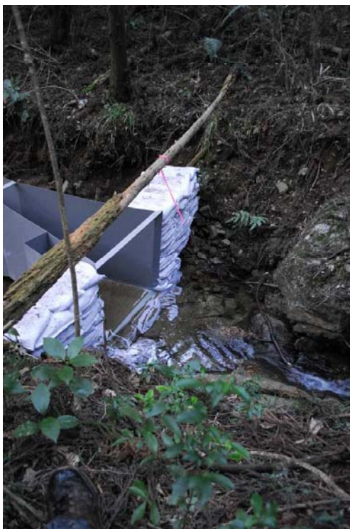
写真3 パーシャル堰き止め状況 * 漏水はなし
