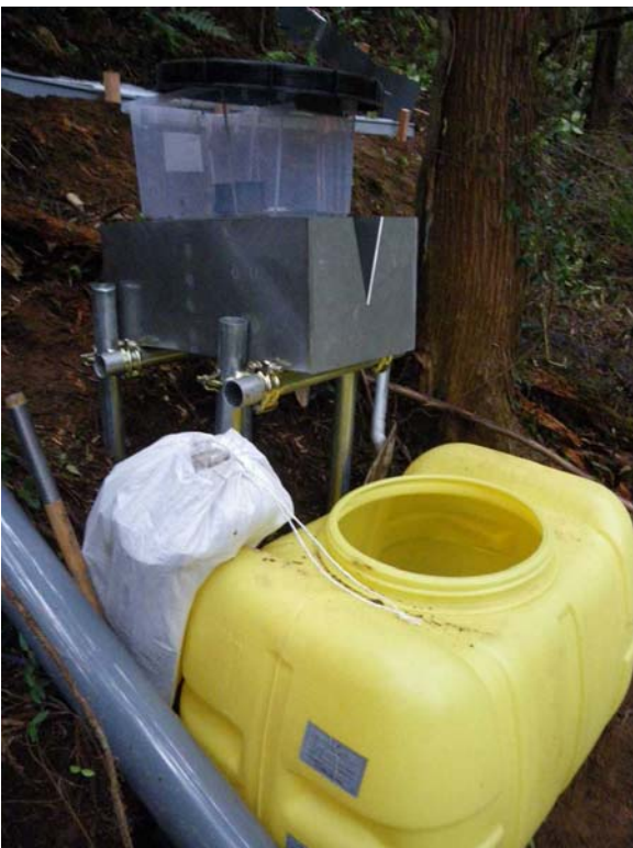
写真2 三角堰と貯水タンクの設置状況
