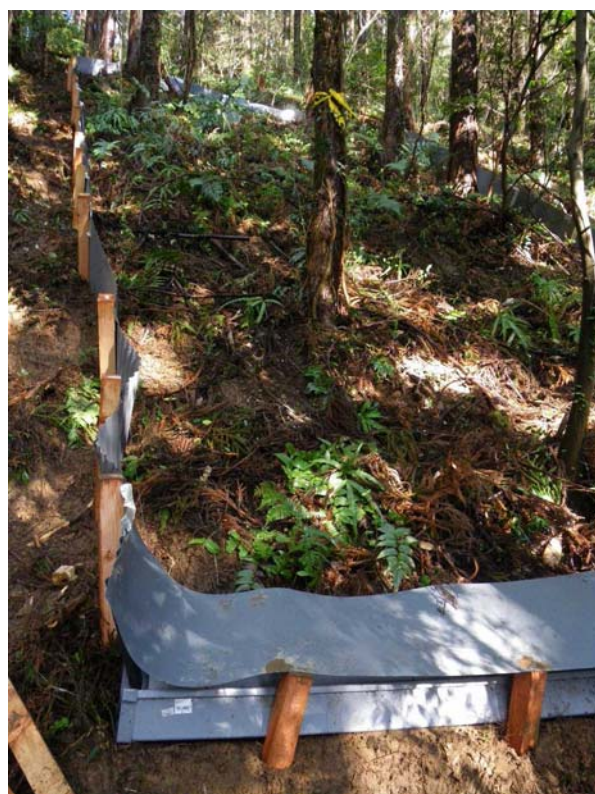
写真3 流出受けの屋根
