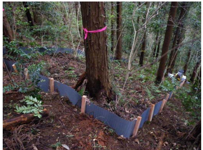
写真4 プロット壁の設置状況(2)
