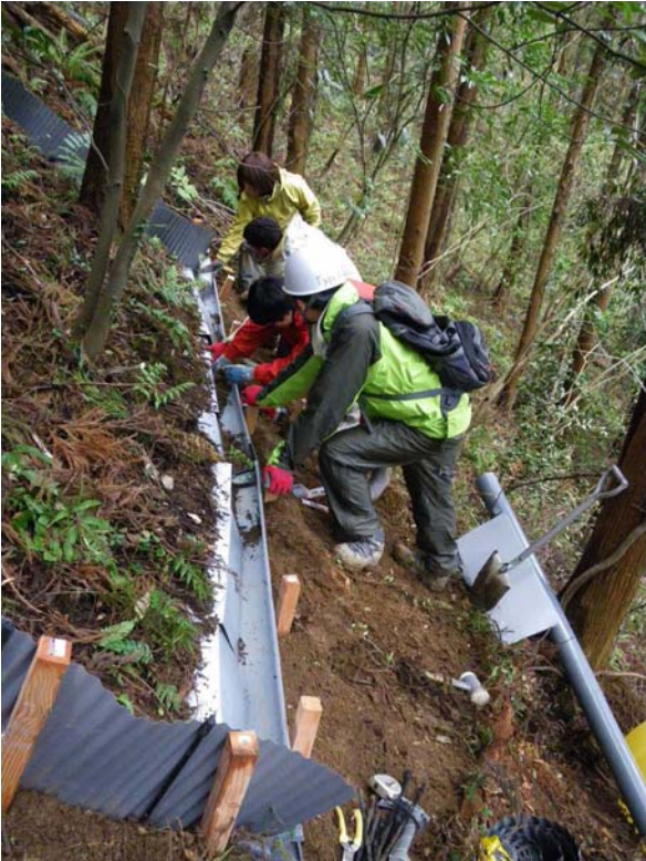
写真1 流出受けの取り付け風景
