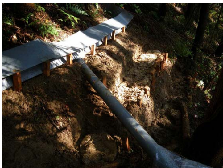
写真2 流出受けからの導水管
