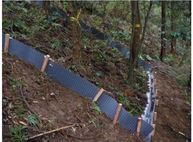
写真3 プロット壁の設置状況(1)
