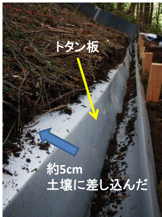
写真2 流出受けの設置状況
