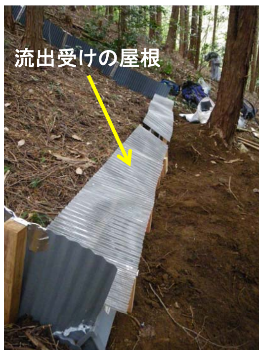
写真4 流出受けの屋根の概観(95%完了)
