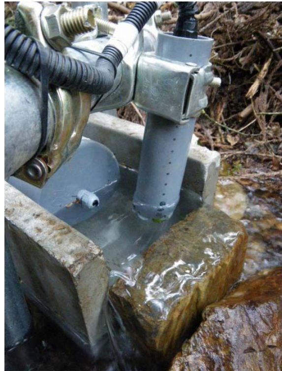
写真14 濁度計センサー部分の取り付け方法
