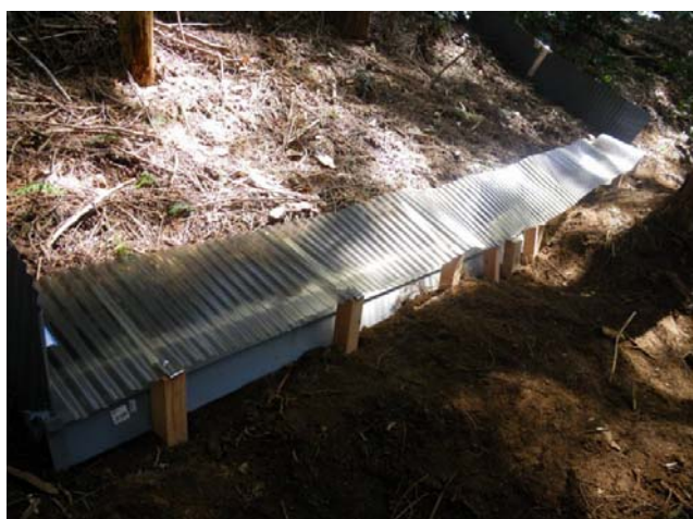
写真6 表面流受けの屋根を閉じたところ
