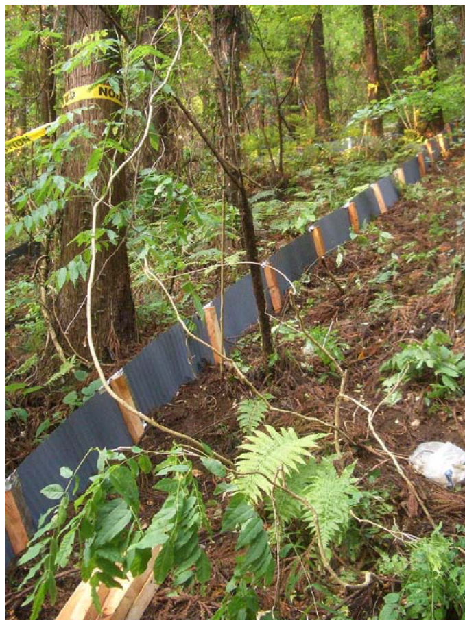
写真2 プロット壁の設置状況
