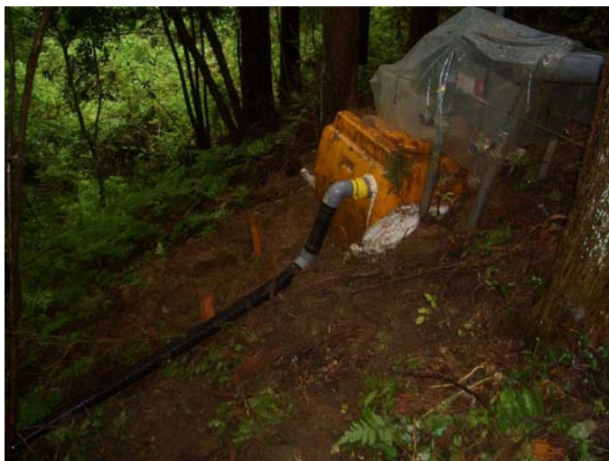
写真8 貯水タンクとドレンホース
