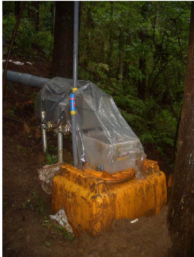
写真7 三角堰・貯水タンク
