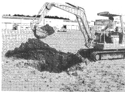
写真1 ヒートプローブ式土壌水分センサー埋設状況(1)
