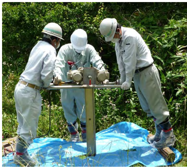
(b) ハンディジオスライサー（幅 10cm×深さ 1m×厚さ 2cm）による掘削調査 （振動機によるハンディジオスライサーの地中への押込み状況）
