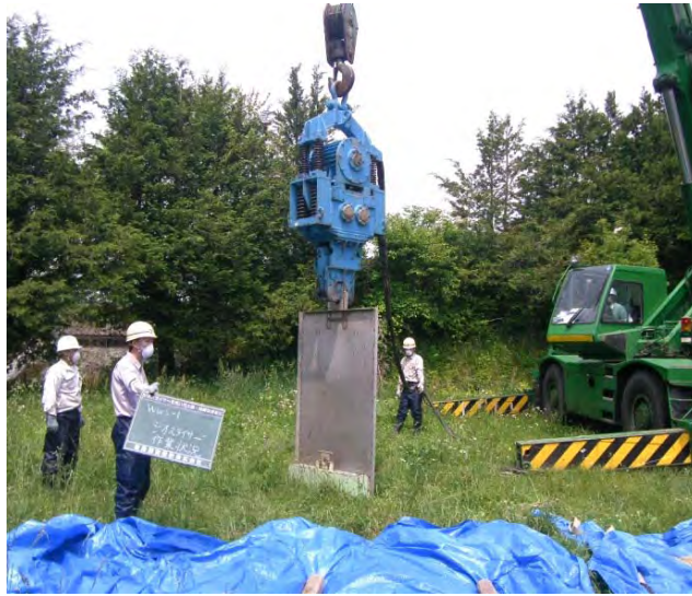
(a) ワイドジオスライサー（幅 1.1m×深さ 1.2m×厚さ 10cm）による掘削調査 （ユニックによるワイドジオスライサーの地中への押込み状況）
