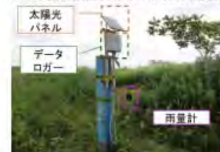
写真5. データロガー・太陽光パネル・雨量計設置状況(岩沼観測所地点)
