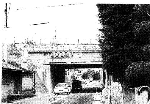
写真1 天井川の景観(印川、市川大門町高田、河床はトンネルの上にある)
